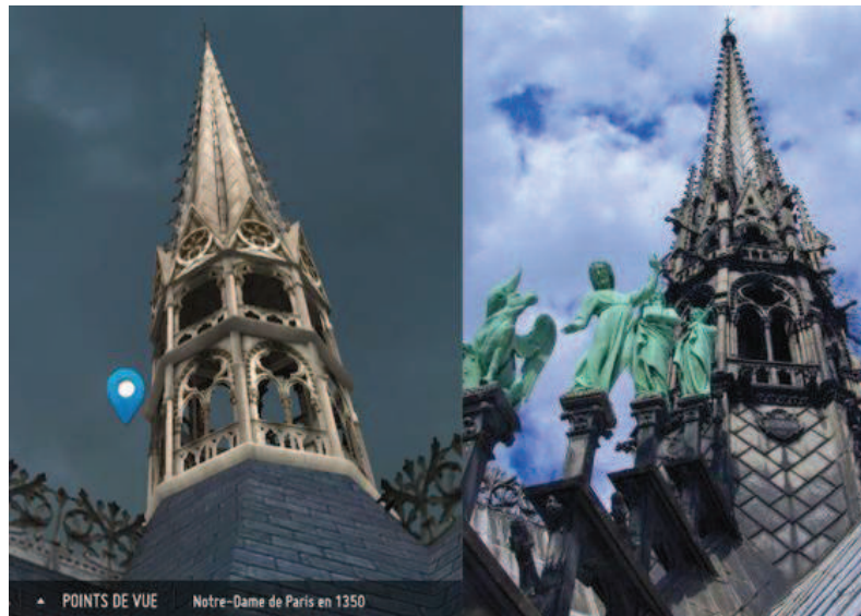
Figure II.44 Comparaison de l'ancienne flèche de Notre-Dame de Paris dans Paris 3D Saga (à gauche) et de celle du XIX e siècle sur le monument existant (à droite)
